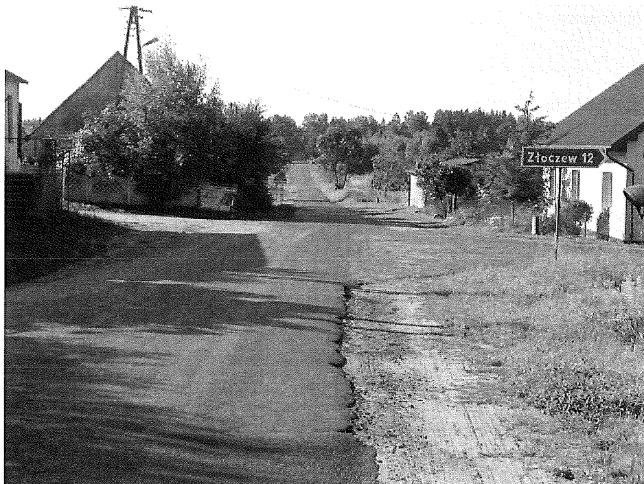
Fot. Skrzyżowanie dróg powiatowych Burzenin-Szyndzielów nr 1704E i Niechmirow-Złoczew nr 1715E z drogą gminną Nr 117352E
